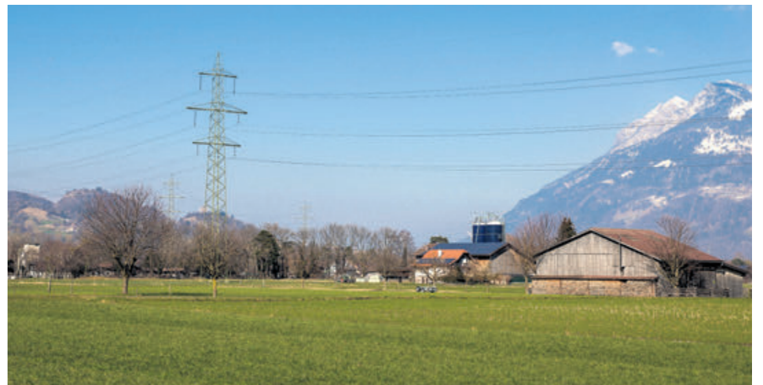
Der Strom soll auch nach August 2021 durch die Leitung fliessen.
