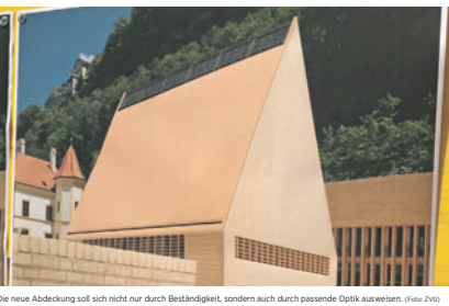
Die neue Abdeckung soll sich nicht nur durch Beständigkeit, sondern auch durch passende Optik auszeichnen. (Foto: ZVL)
